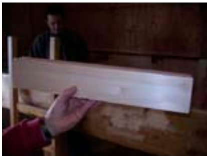
Balken vor Holzwurm
